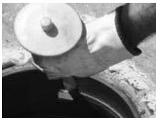
**Paso 5:** Utilizando un cincel y un martillo, remover imperfecciones de metal del contenedor OPW, dejando liso el interior de la pared. Se debe tener cuidado de no romper el borde.
