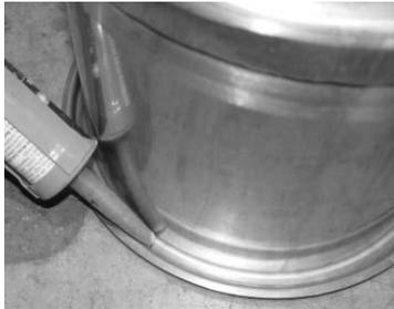
**Paso 12:** Limpiar a fondo la superficie actual de la pared del contenedor de derrames con un cepillo de alambre, a continuación, utilizar un disolvente tal como laca disolvente para asegurar que no haya residuos de grasa sobre la pared. Utilizar el sellador de uretano en el agujero de la parte inferior del casquillo nuevo, para prevenir que las aguas subterráneas entren al casquillo nuevo.
